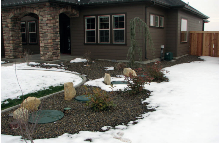
Le « BioBarrier » est disposé sous terre et accessible pour l'entretien.
